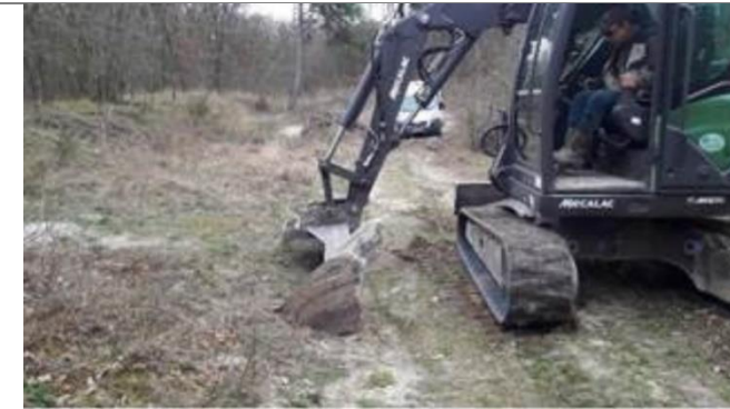
Figure 17 : Pelle munie d'un godet prélevant une dalle de végétation
